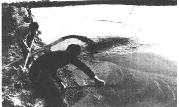
利津县大赵乡根据该县统一部署，大搞荒滩地开发，目前沟渠路配套的4000亩渔农开发区框架初具规模，土方量已完成60%。图为民工正在放淤筑台。
